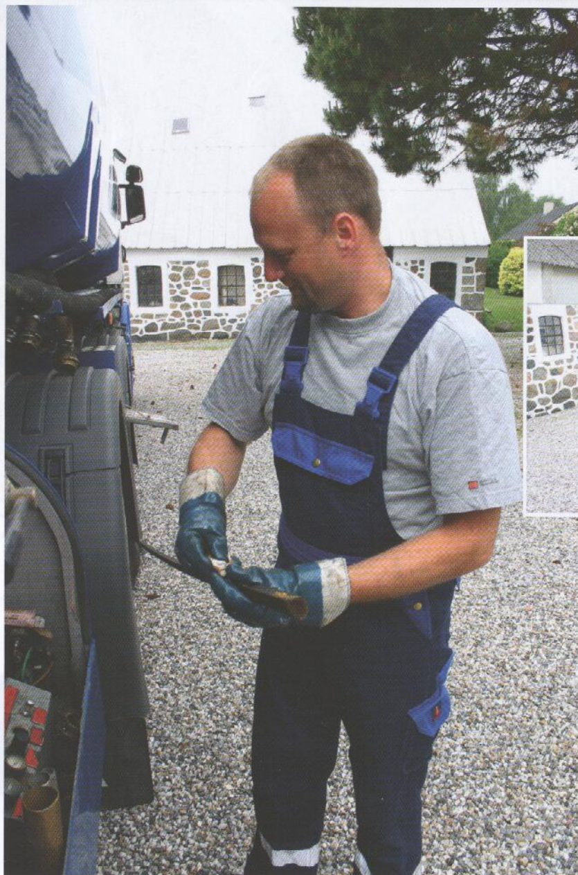
Jordtanken skal sløjfes, og Kim tager først check på olieslamhøjden. Derefter tager det 10 minutter, så er risikoen for udslip væk i al fremtid.
