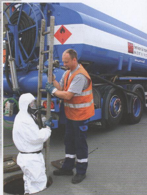
Der skal her kontrolleres en 20.000 liter benzintank. Først bliver mængden konstateret, og så er det i gang med at pumpe den tom.
